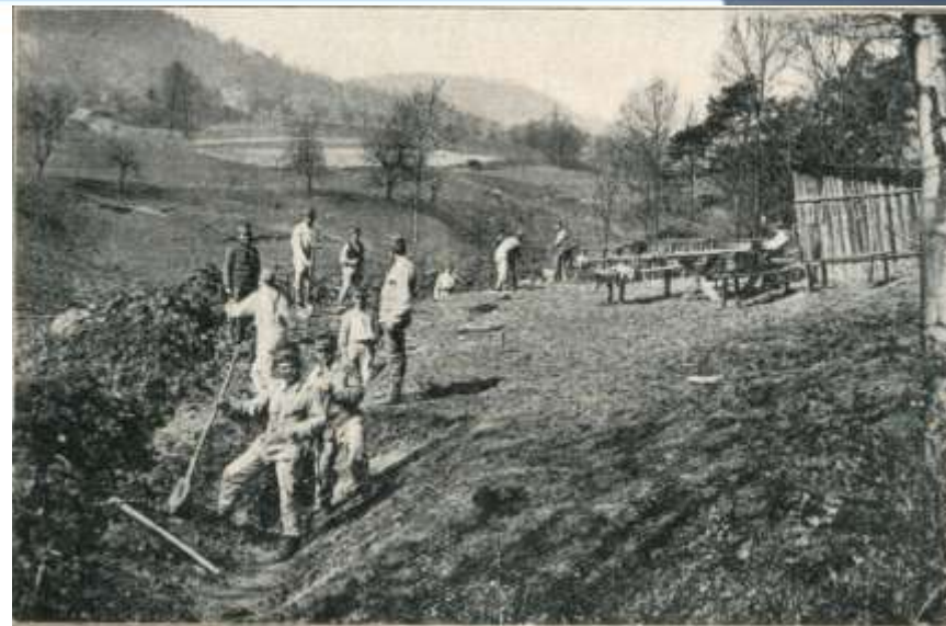
12. April 1914: Pioniere schaffen einen Abflussgraben
