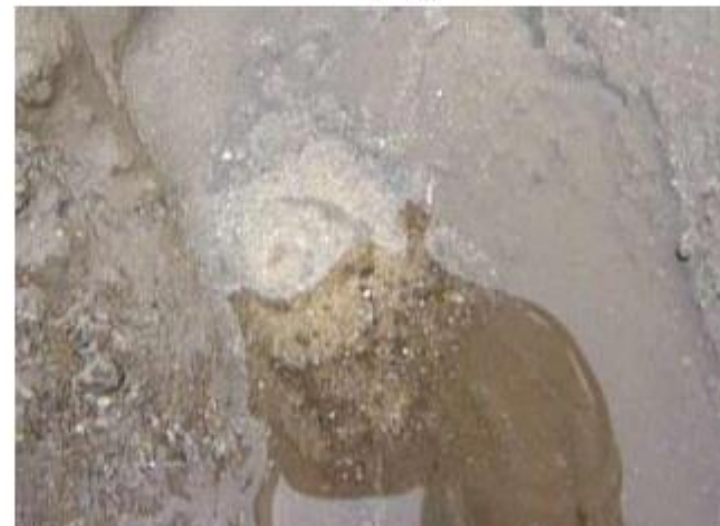
Obr. 3.19 Vyplavování zeminy (Foto - Žatecký)
