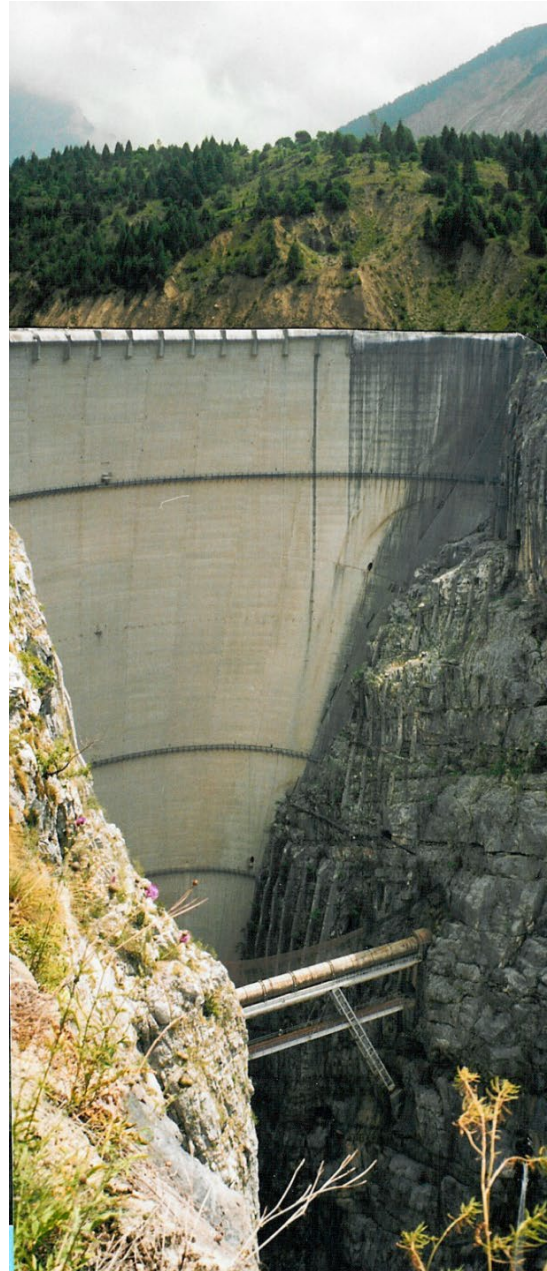
Staumauer Vajont mit Rutschkörper (bewaldet) und Gleitfläche (oben rechts), Foto: Pohl
